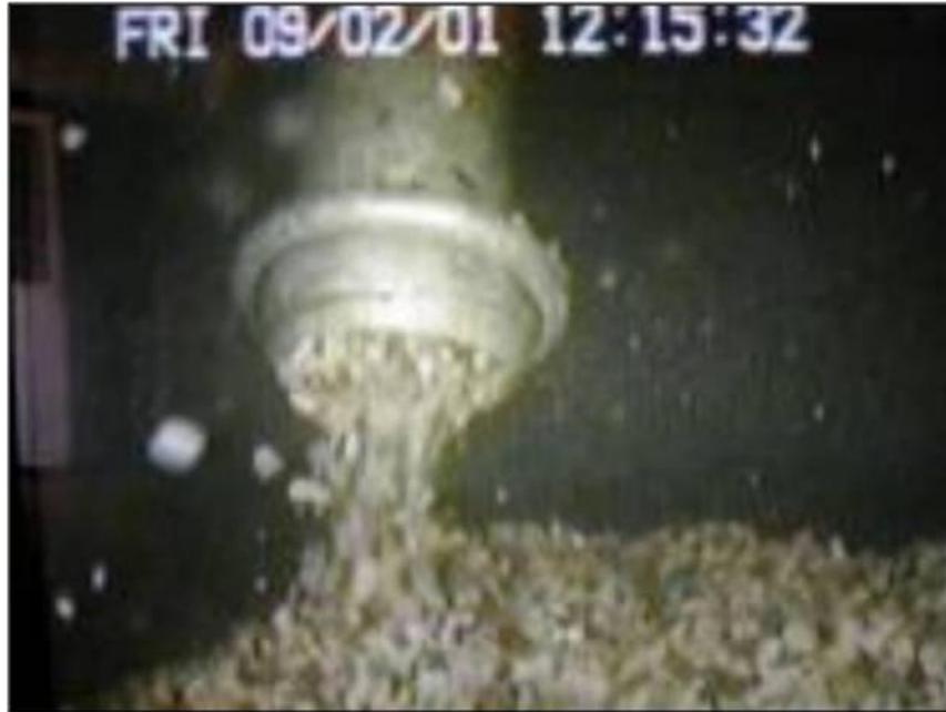
**Figura 29.26.-** Extremo de la tubería descargando el material de relleno en una de las cavidades. (Cortesía del Ing. Carlos Pimentel).
