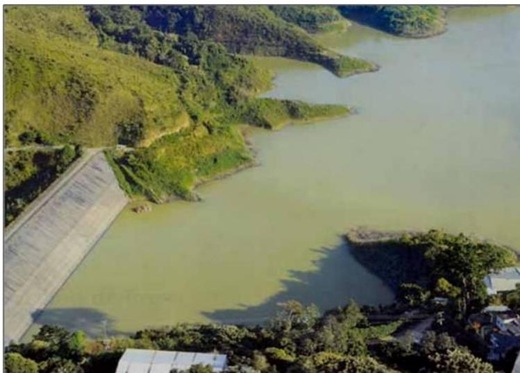
**Figura 9.1.-** Embalse La Pereza. Vista de la pantalla asfáltica del talud aguas arriba de la presa. (Cortesía del MARNR).
