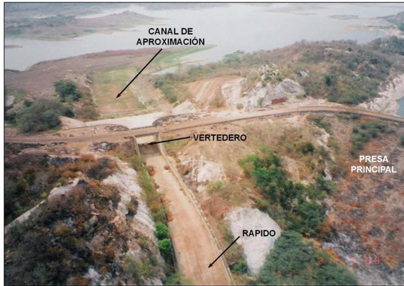
**Figura 33.3.-** Vista del aliviadero (04/1998) (Foto tomada por L.M. Suárez V.).
