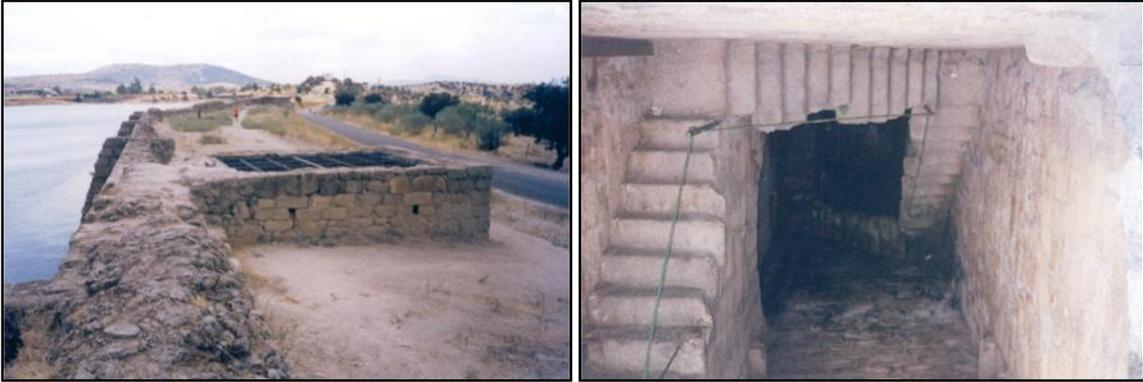
**Figura 1.8.-** Presa Proserpina. Pozos para la toma de agua, adosados al paramento aguas abajo del muro de mampostería. (Fotos tomadas por L.M. Suárez V.).
