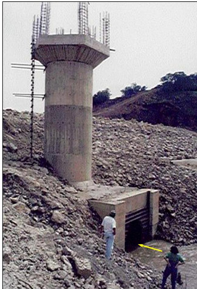
**Figura 22.2.-** Desviación del caudal del río por una abertura en la base de la torre-toma. (Foto tomada por L.M. Suárez V.).
