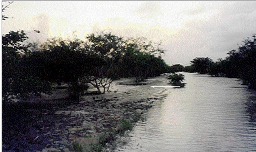
**Figura 28.6.-** Aliviadero de enrocado en funcionamiento (Abril 1999).
