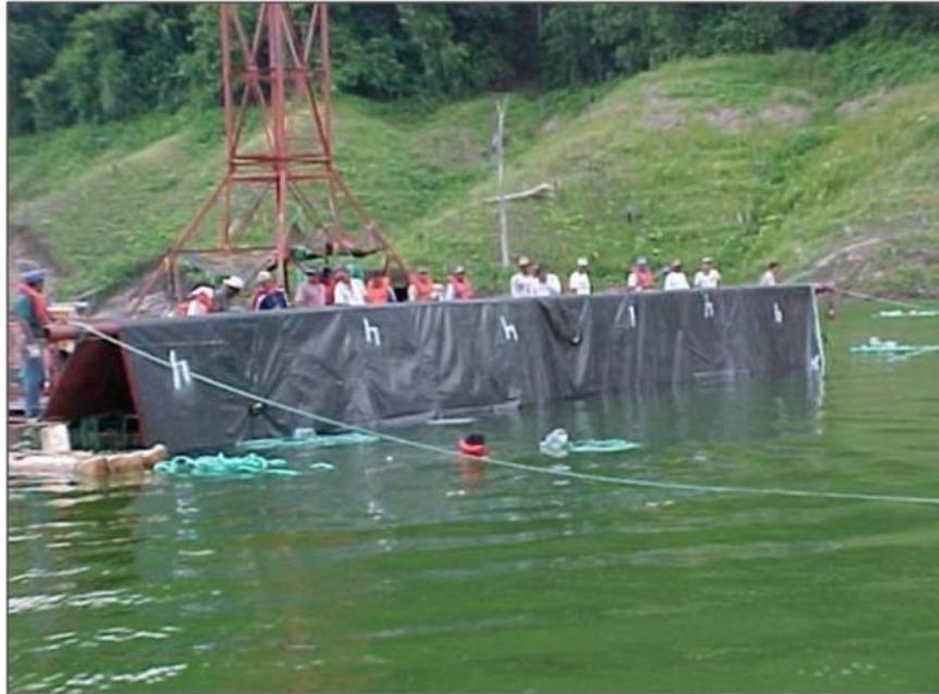
**Figura 29.28.-** Extensión de la membrana aguas arriba mediante la gabarra. (Cortesía del Ing. Carlos Pimentel).
