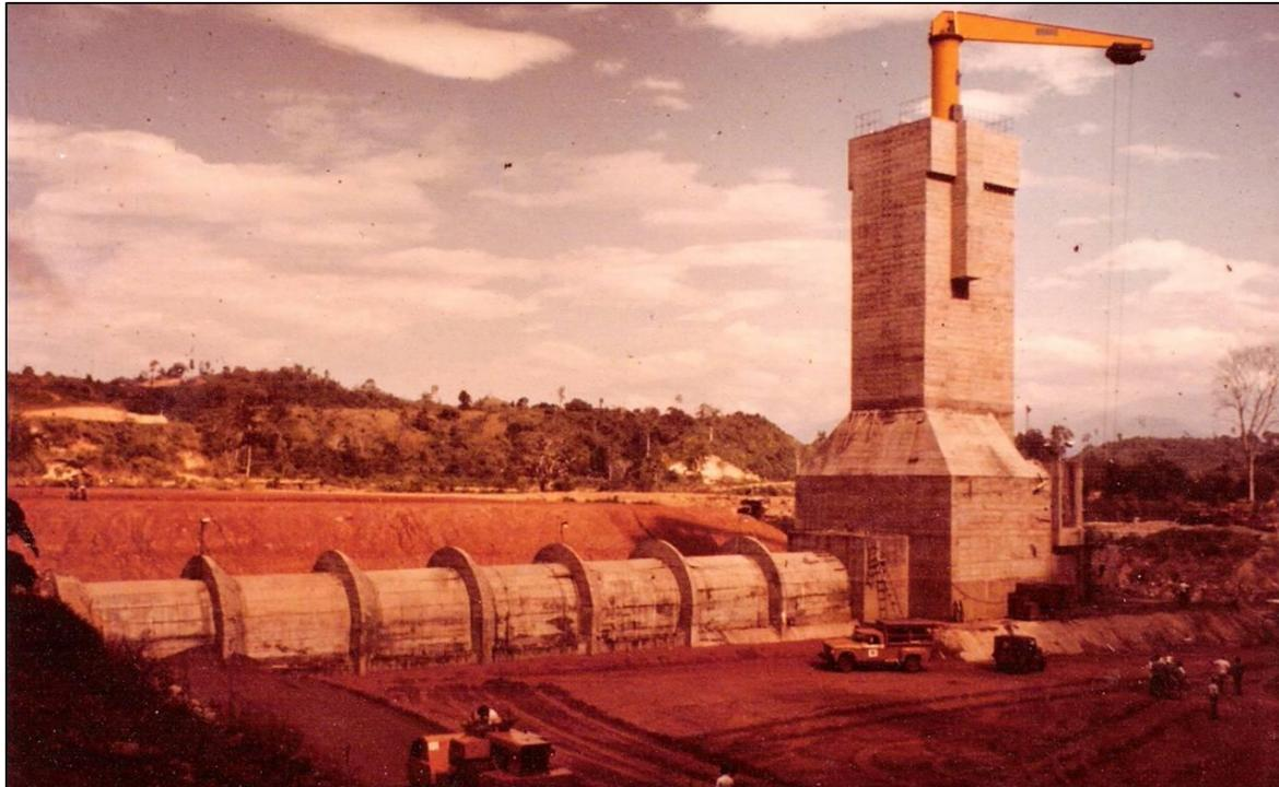
**Figura 32.2.-** Torre y conducto del aliviadero primario. (Cortesía del MARNR).
