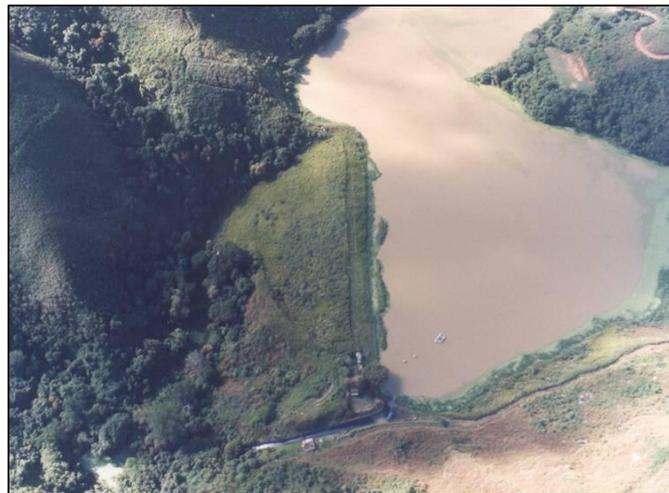
**Figura 1.14.-** Presa Petaquire, única en el país de relleno hidráulico.
