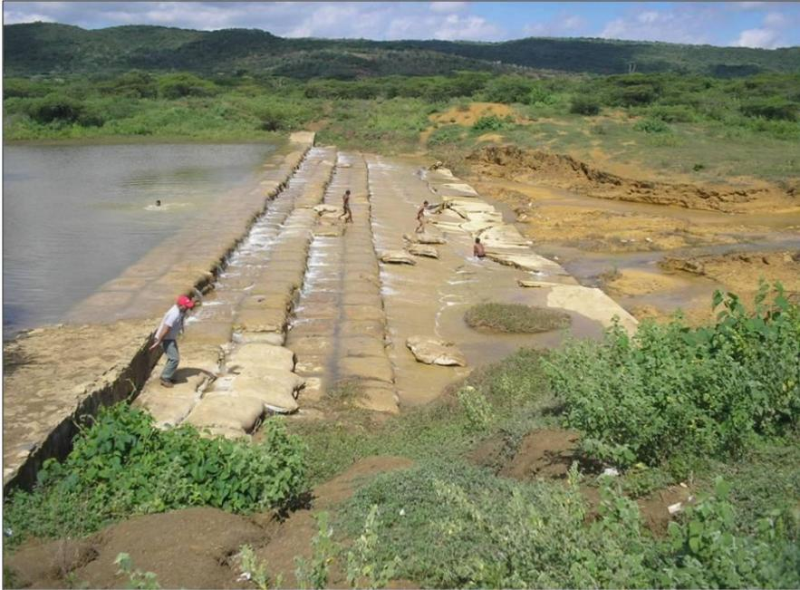
**Figura 30.7.-** Dique – vertedero construido con elementos de bolsacreto en el año 2006.
