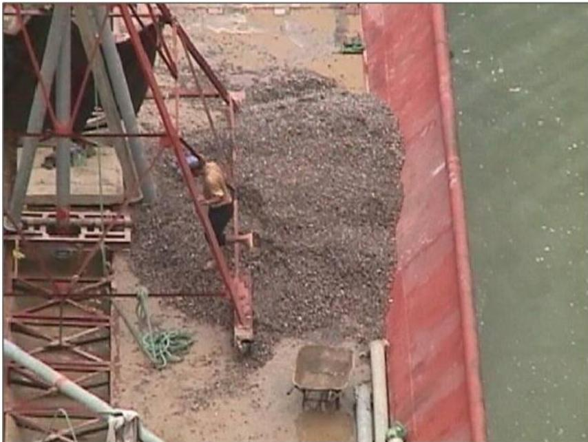
**Figura 29.25.-** Material seleccionado, depositado en la gabarra para su posterior colocación en las cavidades mediante tuberías. (Cortesía del Ing. Carlos Pimentel).
