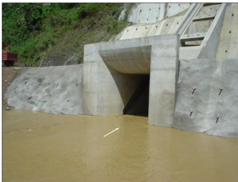
**Figura 27.35.-** Entrada del túnel de desviación. (Foto tomada por L.M. Suárez V.).
