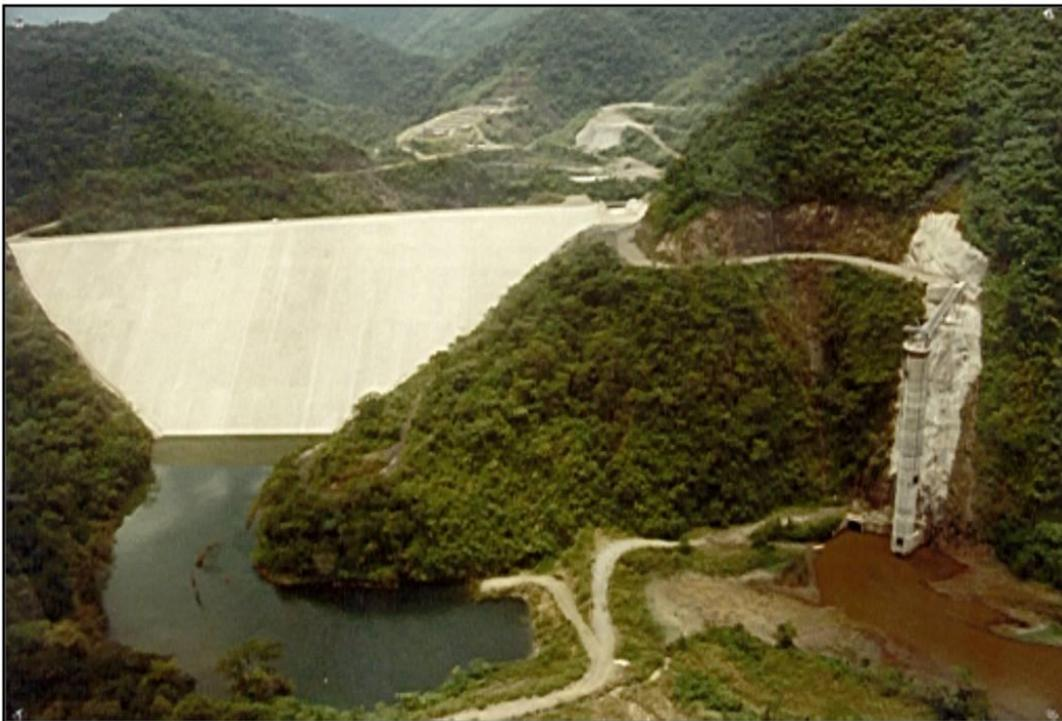
Figura 29.6.- Vista de conjunto de la presa y de la torre-toma, al iniciarse el primer llenado del embalse. (Foto tomada por L.M. Suárez V.).
