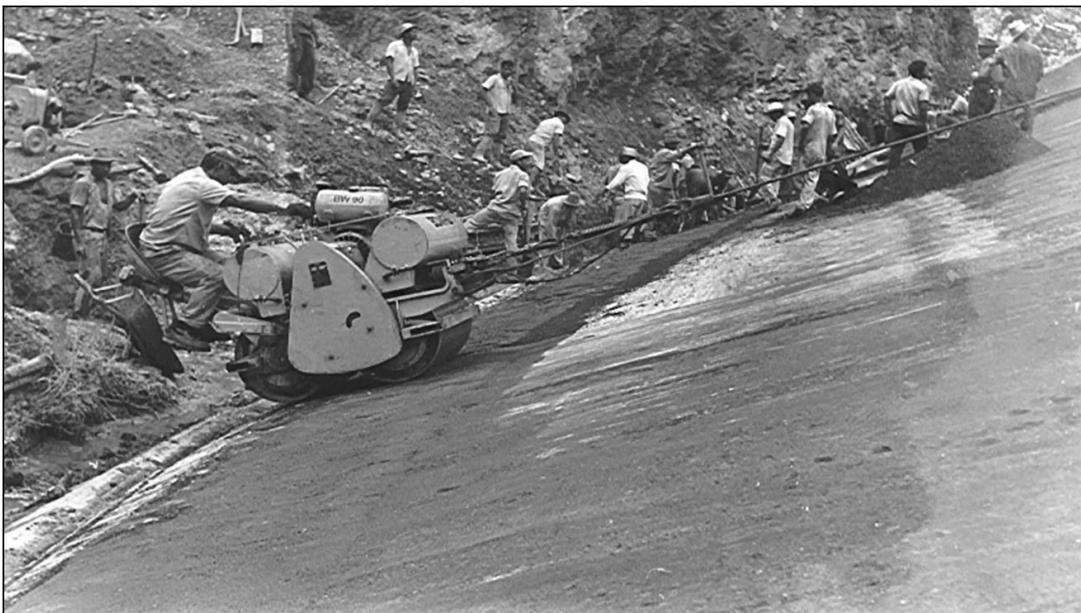
**Figura 9.4.-** Compactación del asfalto en el contacto de la pantalla con el bloque de concreto. (Cortesía del Ing. Pedro Negrón).
