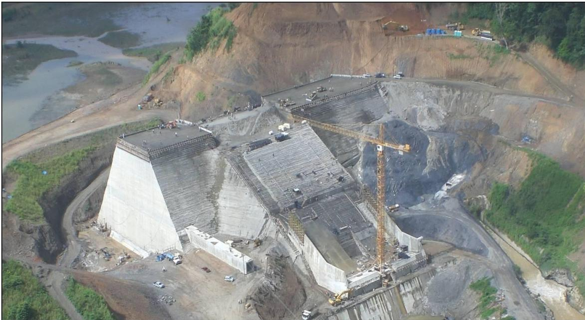
**Figura 27.41.-** Nuevo aliviadero en proceso de construcción sobre el bloque de RCC. (Cortesía de Camargo Correa).
