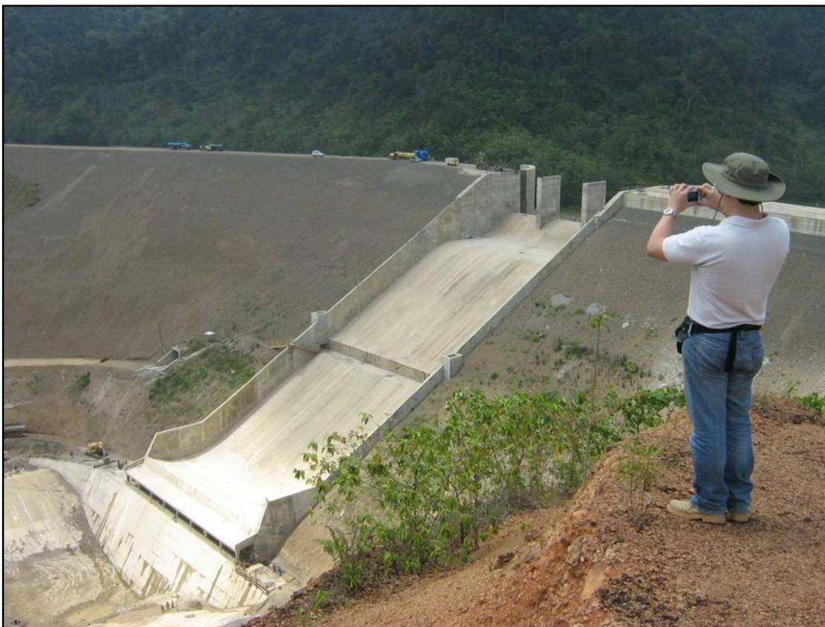
**Figura 27.42.-** Aliviadero prácticamente terminado. (Foto tomada por L.M. Suárez V.).
