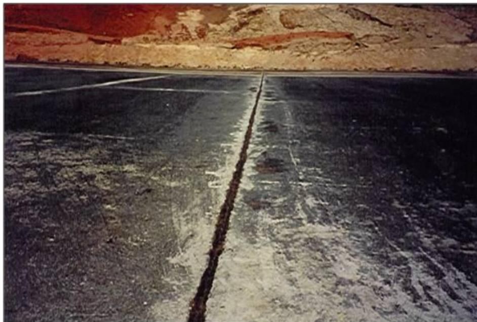
**Figura 17.4.-** Vista de una de las juntas impermeabilizadas con sellador elástico (5/2001). En la parte superior de la foto se ve la berma colocada en la parte inferior de la losa de concreto. (Foto tomada por L.M. Suárez V.).
