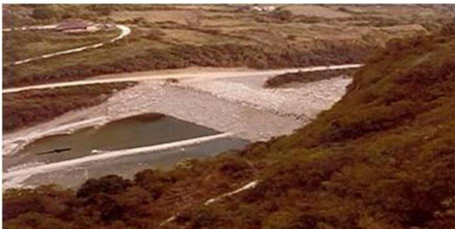
**Figura 20.3.-** Vista del talud aguas arriba de la presa prácticamente terminada. (Cortesía del Ing. Aurelio Trujillo).
