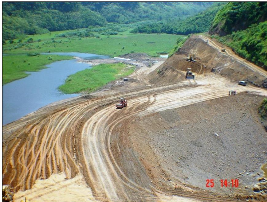
**Figura 27.37.-** Construcción de la ataguía. El flujo está pasando por el túnel de desviación. (Foto tomada por L.M. Suárez V.).
