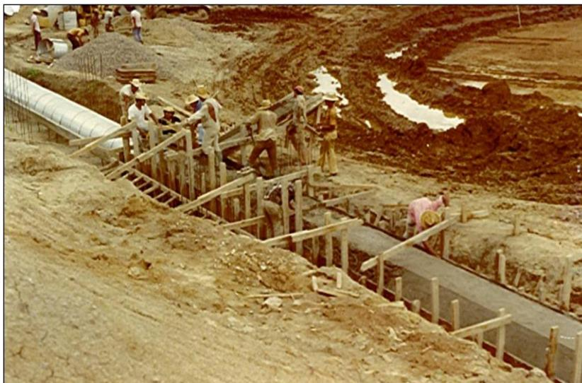
**Figura 16.2.-** Construcción del conducto de toma, formado por una tubería de acero galvanizado, corrugado, revestida exteriormente en concreto. (Cortesía del MARNR).
