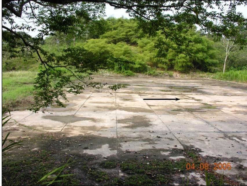
**Figura 32.4.-** Losa horizontal en la entrada del canal del aliviadero secundario.
