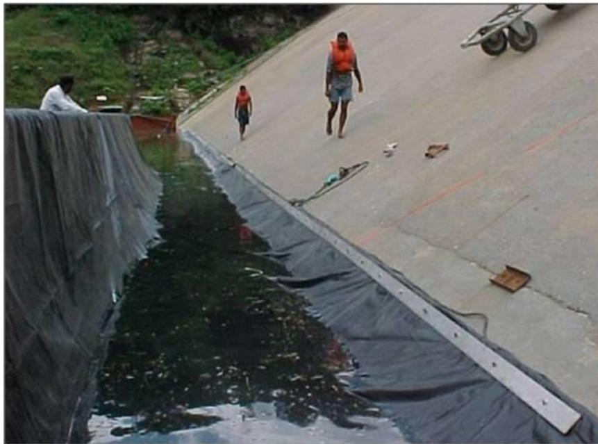
**Figura 29.27.-** Colocación de la membrana plástica sobre el relleno que cubre la zona fracturada de la losa. (Cortesía del Ing. Carlos Pimentel).
