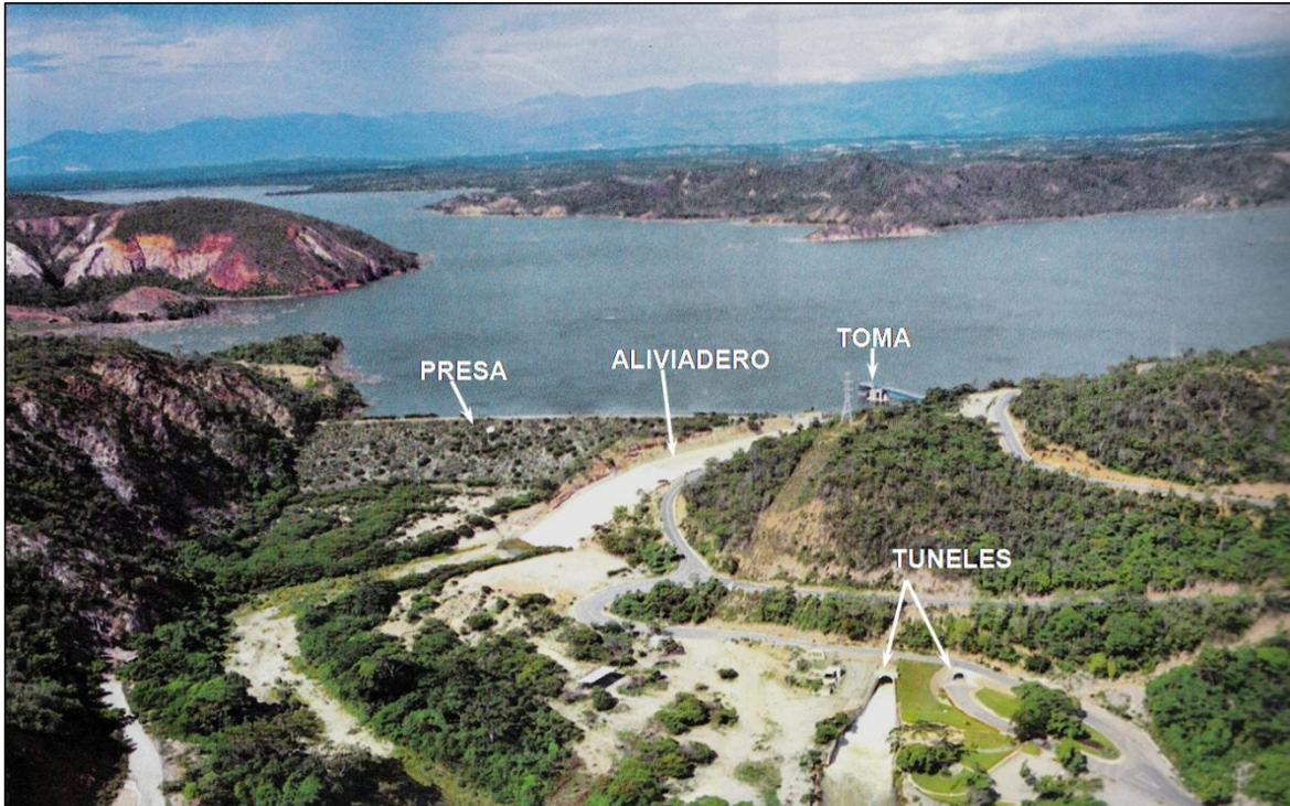
**Figura 23.1.-** Vista de conjunto de la Primera Etapa del embalse, actualmente en operación. (Cortesía del MARNR).
