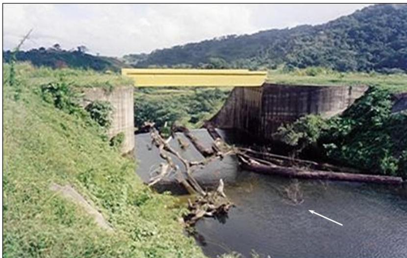
**Figura 27.13.-** Canal de aproximación y puente sobre el vertedero del aliviadero en canal (Enero 1999). (Foto tomada por L.M. Suárez V.).
