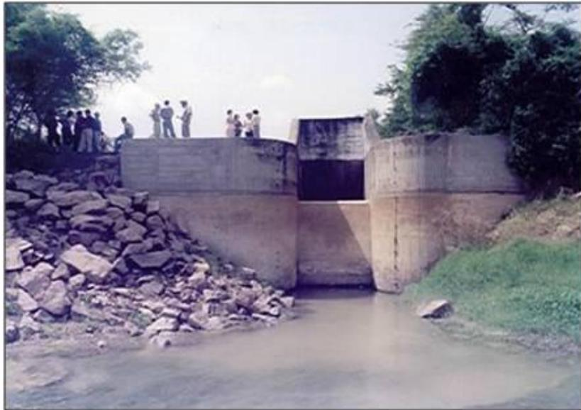
**Figura 26.1.-** Estructura de entrada del aliviadero.
