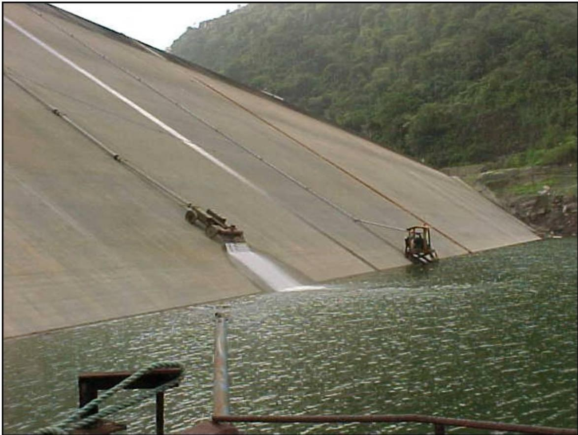
**Figura 29.23.-** Barredora siendo bajada por la losa de concreto de la presa.
