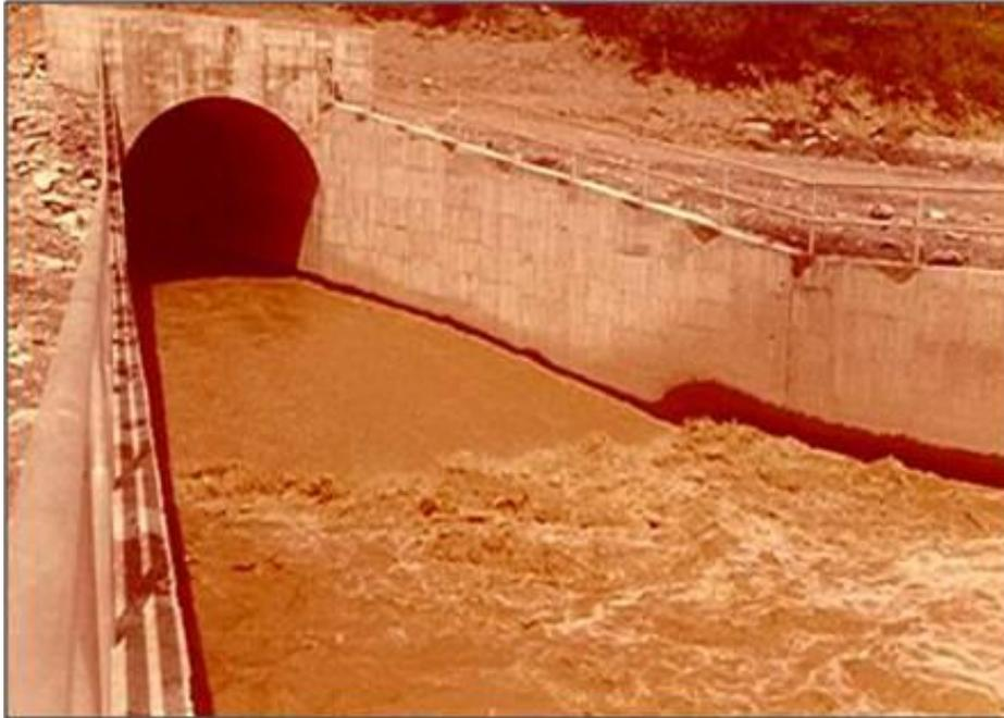
**Figura 23.4.-** Disipador de energía del túnel principal durante la etapa de desviación. (Foto tomada por L.M. Suárez V.).
