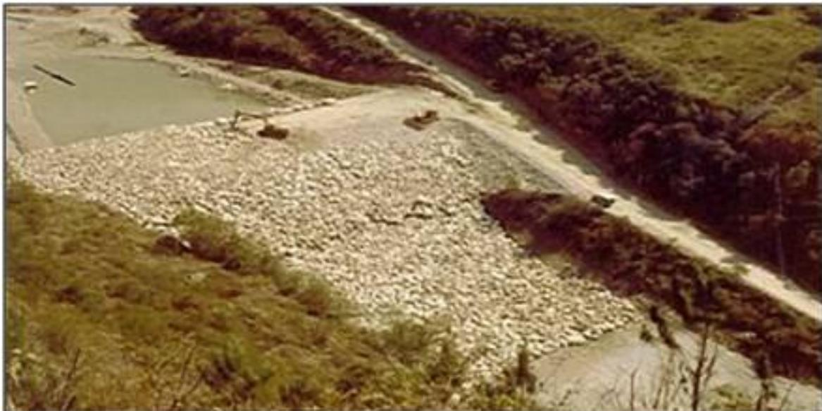
Figura 20.2.- Proceso de terminación de la colocación del enrocado.
