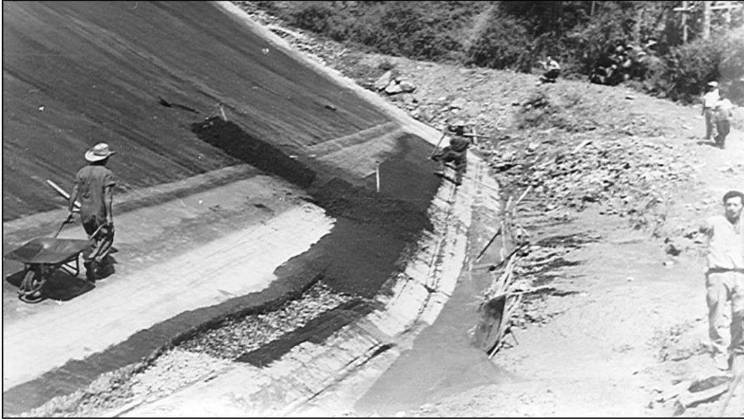
**Figura 9.3.-** Construcción de la unión de la pantalla asfáltica con el bloque de concreto. (Cortesía del Ing. Pedro Negrón).
