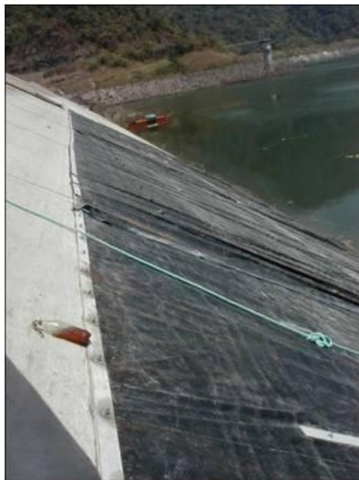
**Figura 29.29.-** Membrana instalada. (Cortesía del Ing. Carlos Pimentel).
