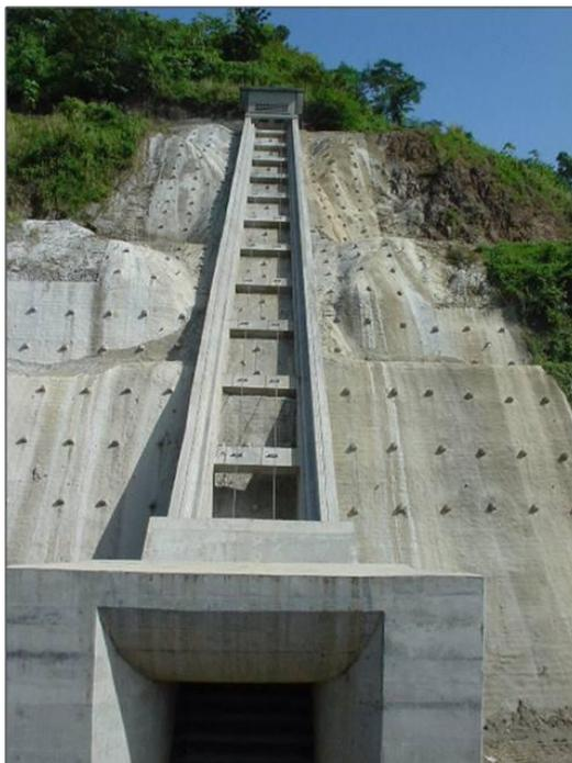
**Figura 27.34.-** Entrada del túnel de desviación. Rampa inclinada para la compuerta rodante. (Foto tomada por L.M. Suárez V.).
