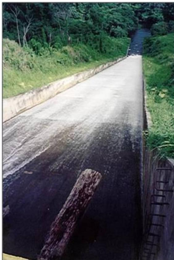
**Figura 27.14.-** Rápido del aliviadero en canal (Enero 1999). (Foto tomada por L.M. Suárez V.).
