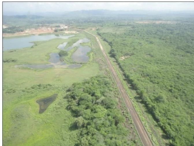
**Figura 33.2.-** Presa secundaria o dique de cierre a lo largo de la fila divisoria del estribo derecho (Foto tomada por L.M. Suárez V.).
