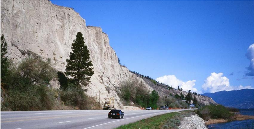
Figure 14. Example of a silt bluff block failure (N. Skermer).
